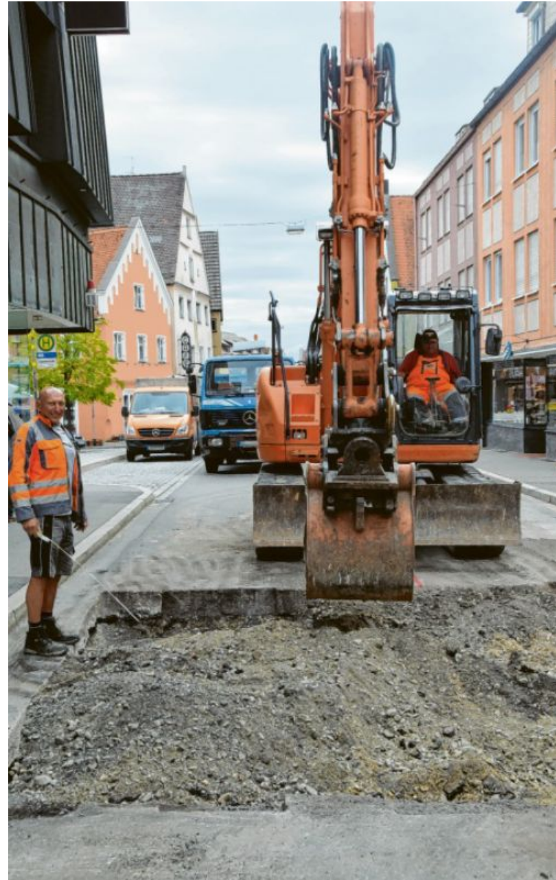
Kleine Baustelle, große Auswirkung: Wegen eines Kanalrohrs eines Hausanschlusses, das ausgetauscht werden muss, ist die Kapuzinerstraße gesperrt. Fotos: Berthold VEH
