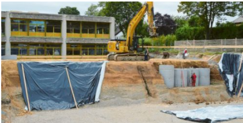
Eine gewaltige Baugrube tut sich auch an der Lauinger Straße in Dillingen auf: Dort entsteht der 23,5 Millionen Euro teure Neubau der Mittelschule.
